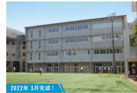
2022年 3月完成！ □ 1号館 東棟
